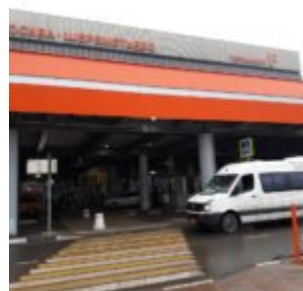
Шереметьево, зона прилета терминала F, 1 этаж, возле входа № 1
